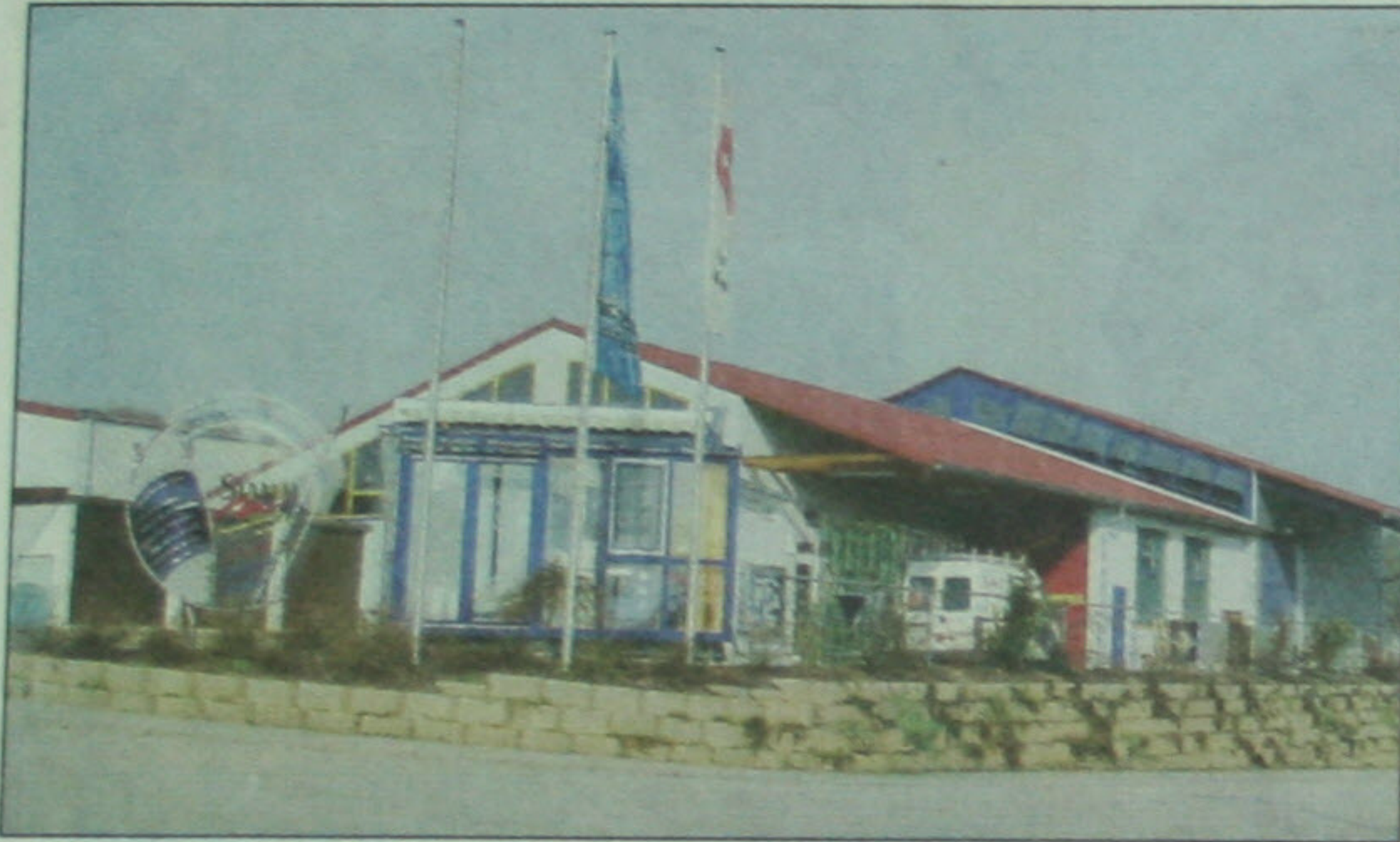
Die Produktionshalle der Firma Stamm Metallbau GmbH.
